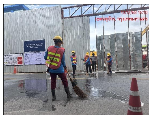
รูปที่ 12 คนงานคอยฉีดพรมน้ำ และกวาดฝุ่น การรื้อถอนของเศษหินและดินที่ตกหล่น
