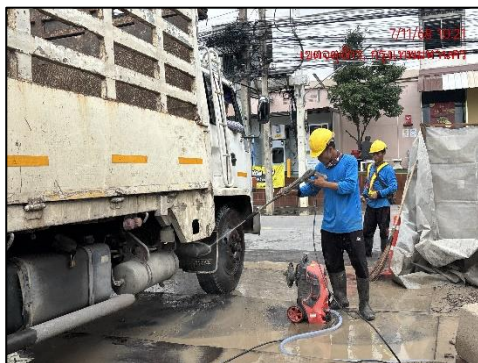
รูปที่ 19 พื้นที่ล้างทำความสะอาดล้อรถบรรทุก
