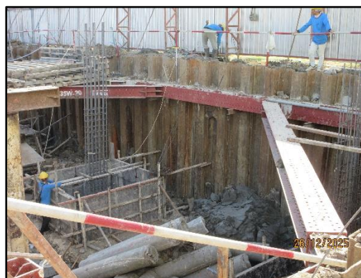
รูปที่ 7 กำแพงดิน (Sheet Pile)
