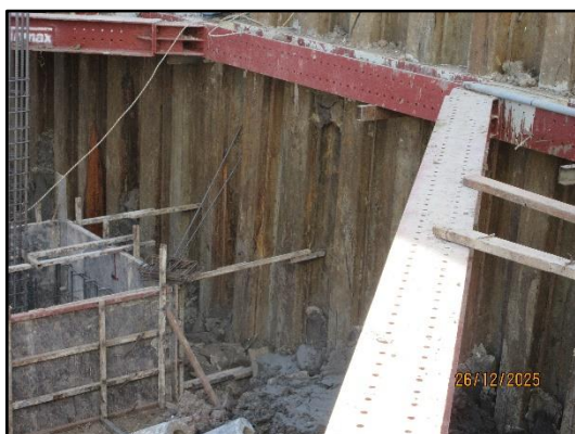
รูปที่ 7 กำแพงดิน (Sheet Pile)
