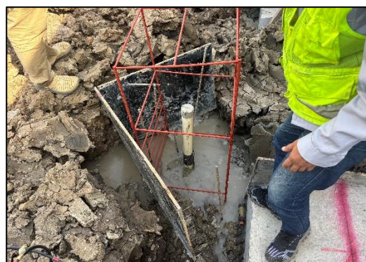
รูปที่ 6 เครื่องมือวัดการเคลื่อนตัวของดิน
