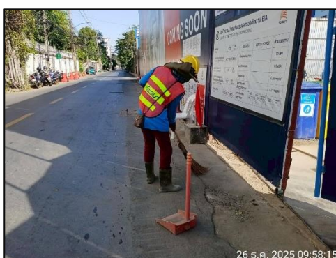
รูปที่ 12 คนงานคอยฉีดพรมน้ำ และกวาดฝุ่น การรื้อถอนของเศษหินและดินที่ตกหล่น
