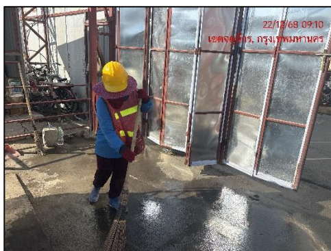
รูปที่ 12 (ต่อ) คนงานคอยฉีดพรมน้ำ และกวาดฝุ่น การร่วนหล่นของเศษหินและดินที่ตกหล่น
