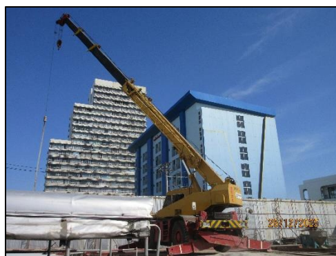
รูปที่ 36 แขนของเครนอยู่เฉพาะภายในพื้นที่โครงการเท่านั้น
