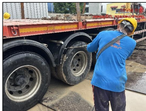
รูปที่ 19 พื้นที่ล้างทำความสะอาดล้อรถบรรทุก
